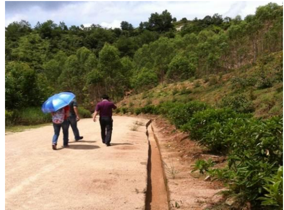
原露天采场生态恢复现状（治理后）
