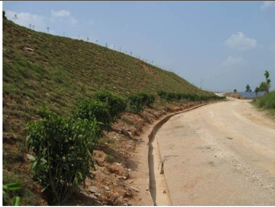
原露天采场生态恢复现状（治理后）
