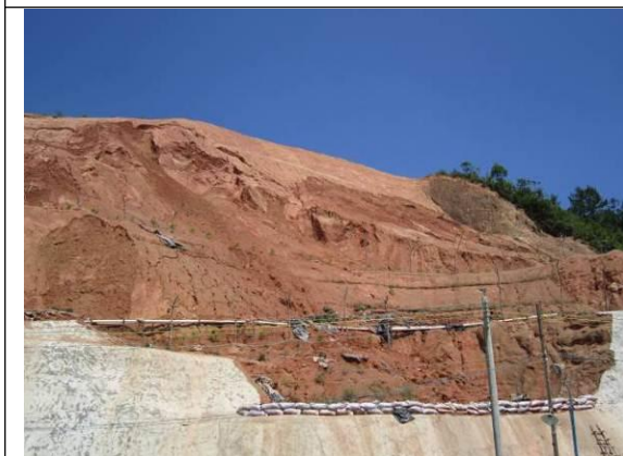
原露天采场边坡降坡形成二级平台
