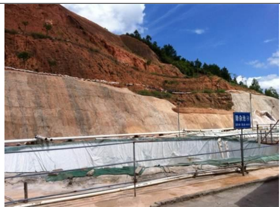
原露天采场降坡后二级平台绿化现状
