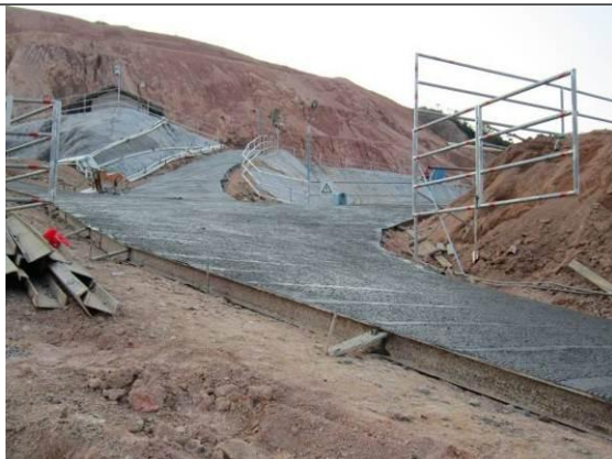
矿区道路硬化
