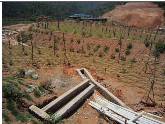
铺设排水涵管
