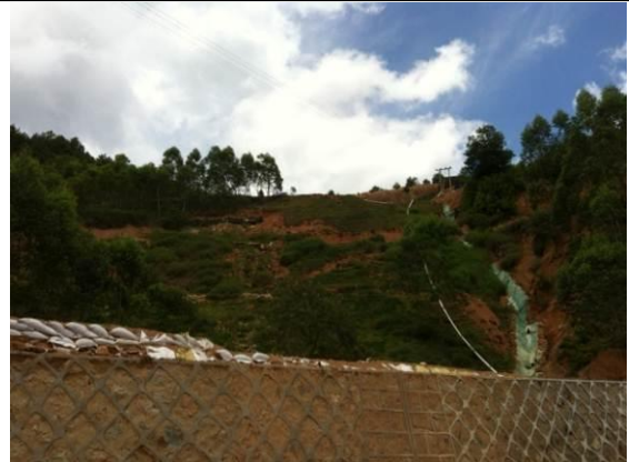
原排土场生态恢复现状（治理后）
